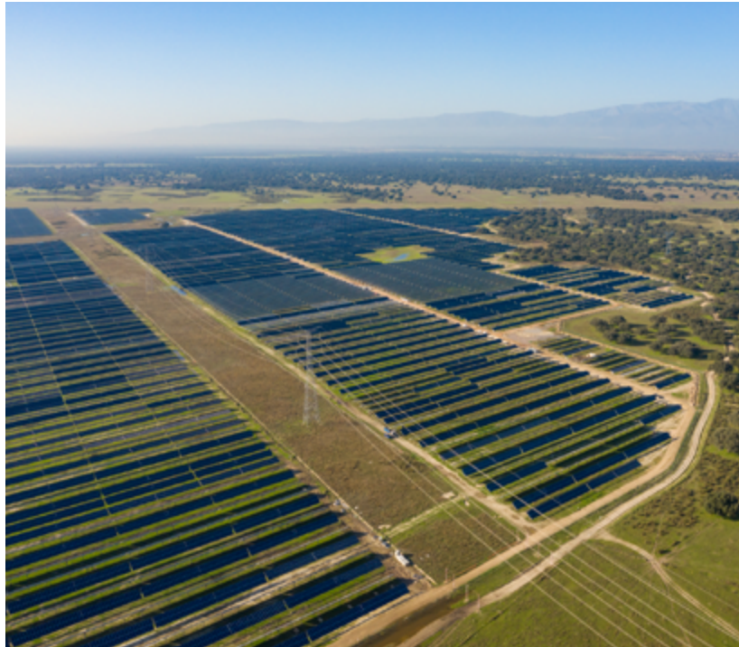
Mit 300 MW ist das Photovoltaik-Kraftwerk in Talayuela (Spanien) das bisher größte PPA-Projekt, das Encavis realisieren konnte.
