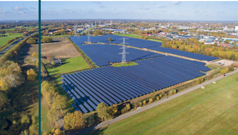
Der niederländische Solarpark „Budel“ entstand auf der industriellen Brachfläche einer ehemaligen Zinkschmelze.
